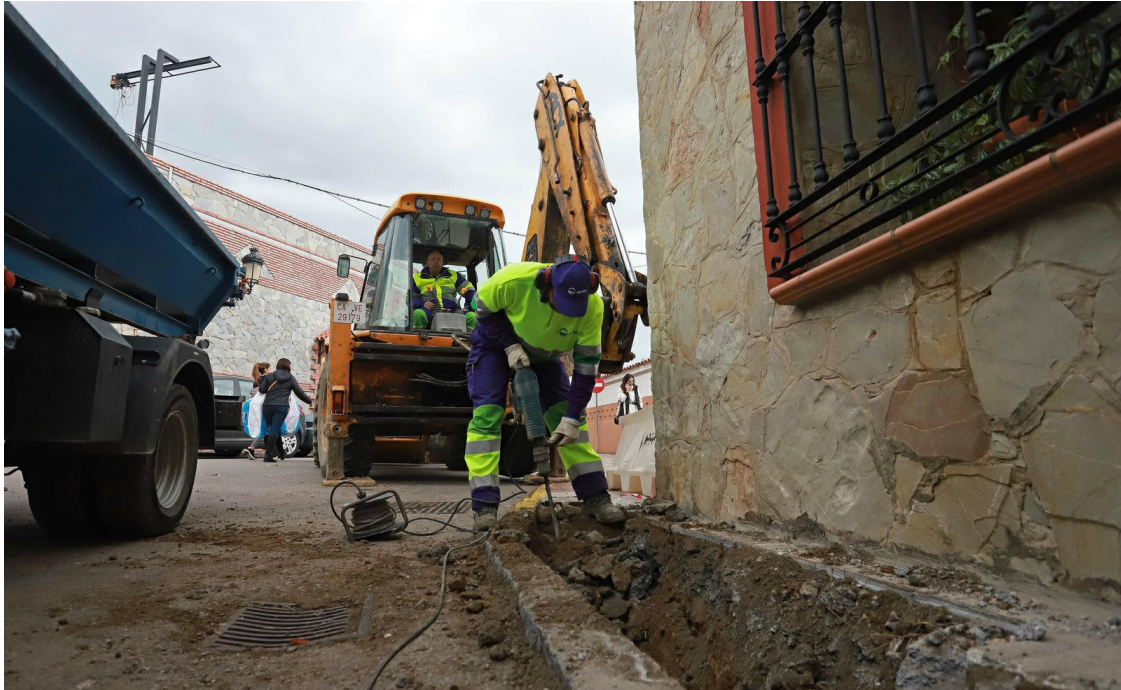
Un trabajador de Arcgisa repara una avería en la red de aguas de Los Barrios.
