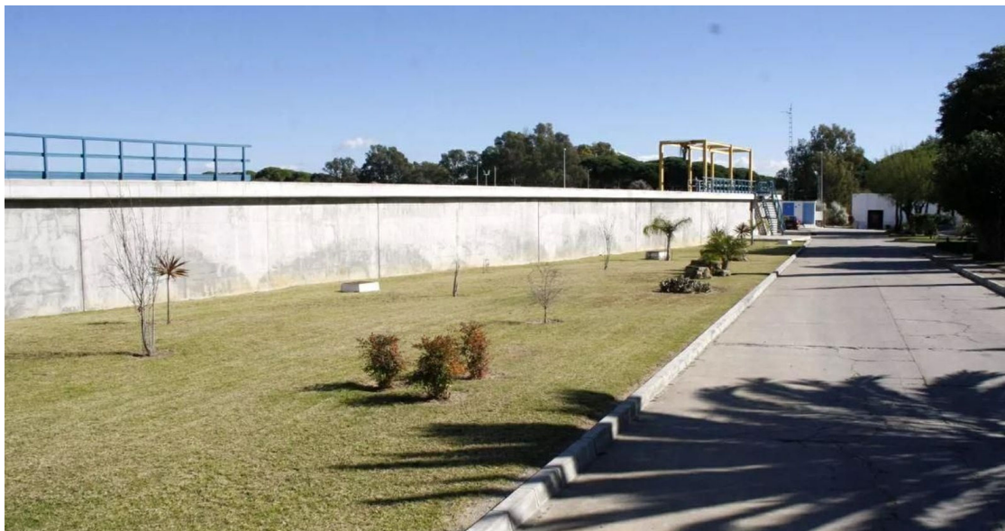
Una imagen de la depuradora de Las Galeras.
