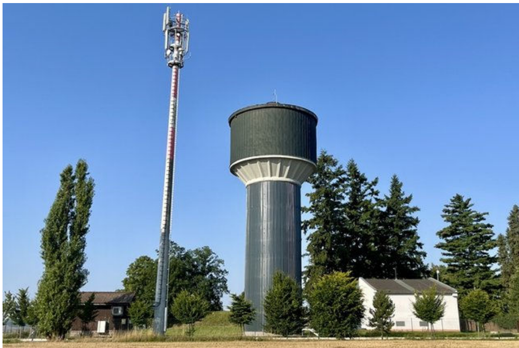
zdroj: Vodojem Opava/ SmVaK
