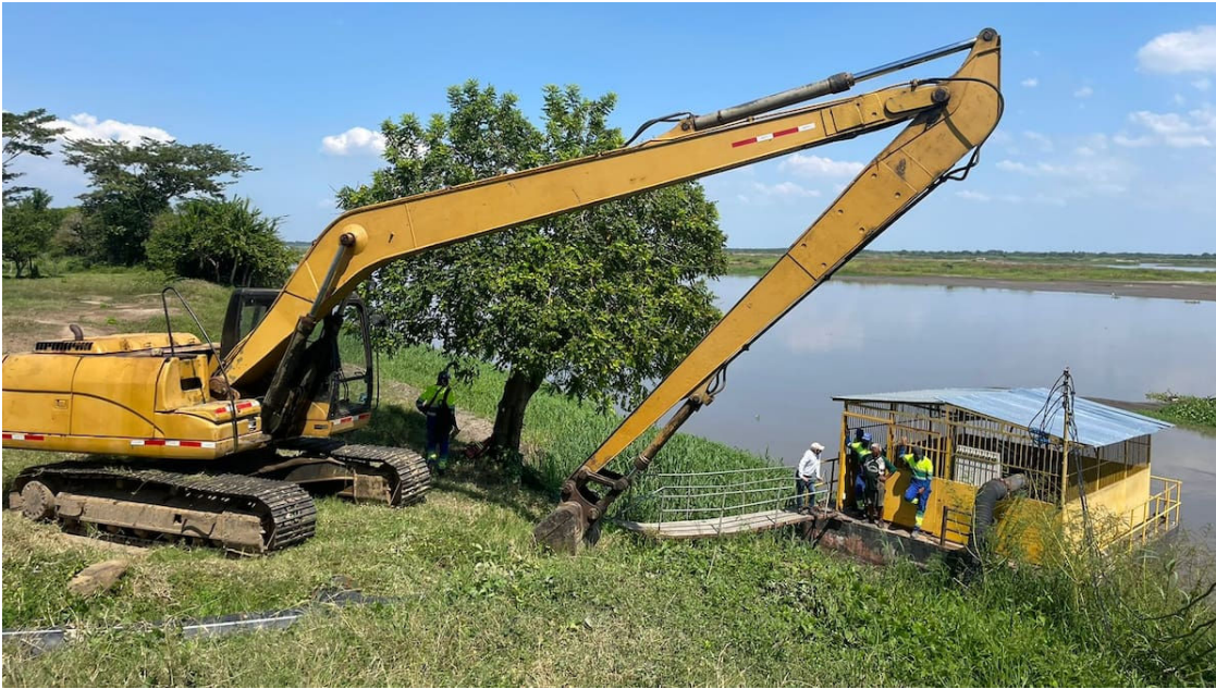
En Campo de la Cruz se preparan con maquinaria amarilla.
